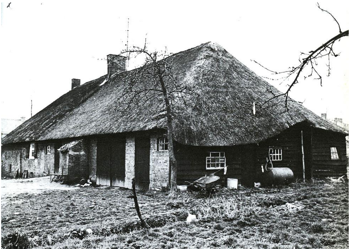
2. Achterzijde van de boerderij ter plaatse.
